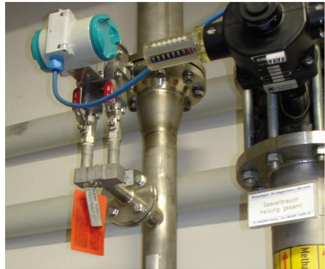
deltaflow für Biogasmengenmessung
